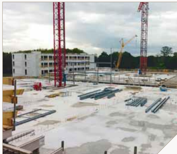
Fig. 1. Meander Medisch Centrum in aanbouw.
