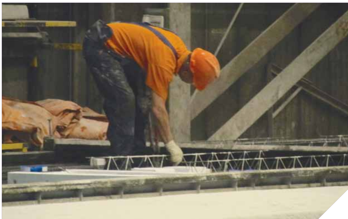
Fig. 3: Tralieliggers klaarzetten ten behoeve van voorgespannen breedplaatvloer.
